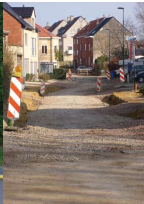
Wegwerkzaamheden aan de De Burburelaan.
