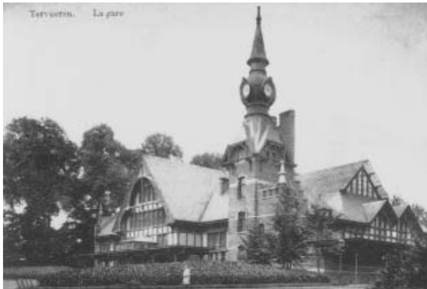
Station Tervuren aan de Leuvensesteenweg (1930)
