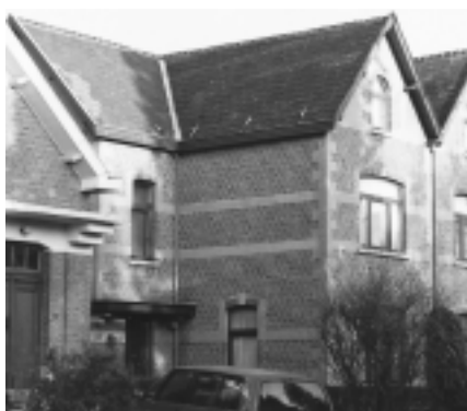
Woning van F. Landrain in de Frans Landrainstraat 6
