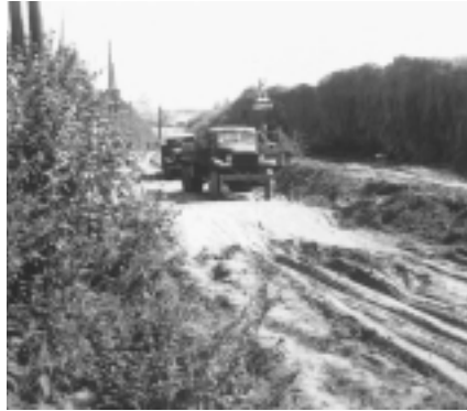
Omstreeks 1950 werd de Lange Eikstraat verbreed en van een betonbedekking voorzien.
