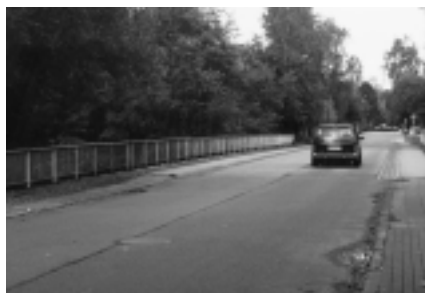
Brug over de Ring aan de de Grunnelaan Anno 2001
